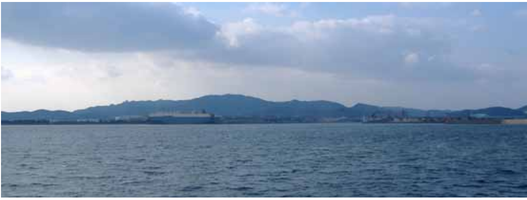
蒲郡港: すぐにも必要な-11m岸壁は長年の懸案となっている
