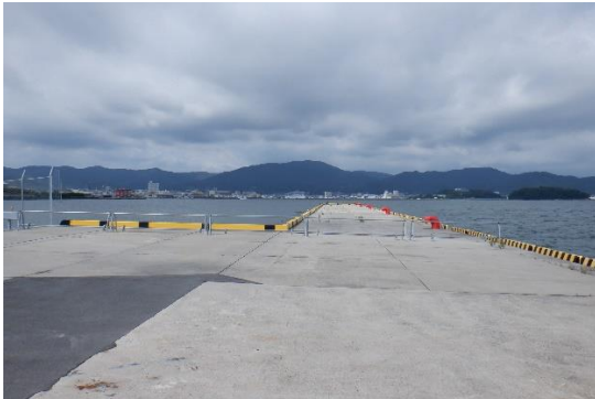
② 延伸中の 11 号岸壁
