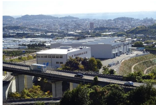
③ 蒲郡西 IC 直近の工場
