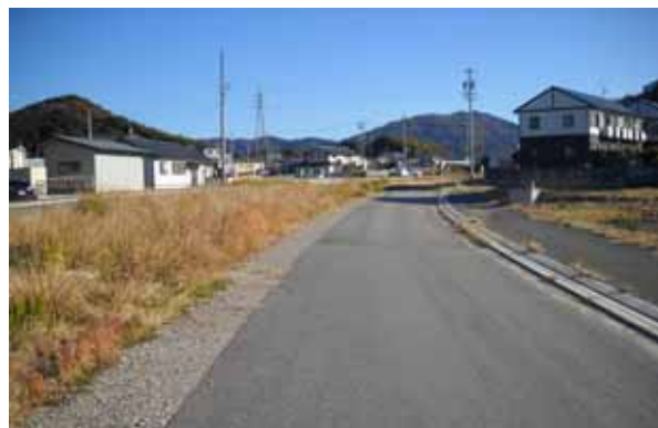
工事が進む国道247号バイパス
