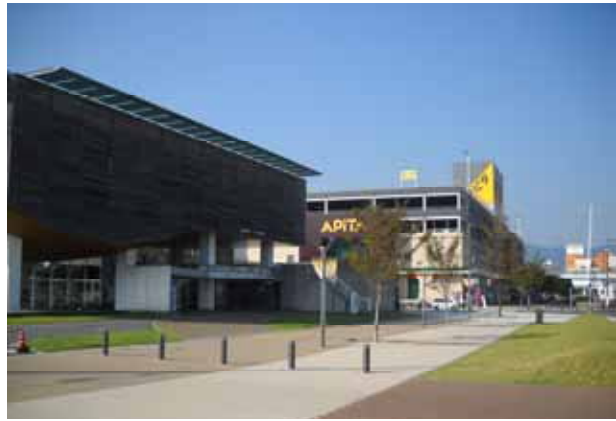
整備の進んだ生命の海科学館周辺
