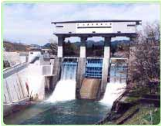
新城市鳳来地区の大野頭首工
