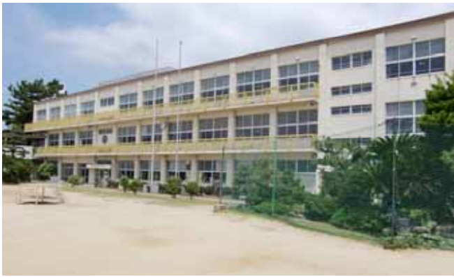
耐震化工事が行われる形原小学校
