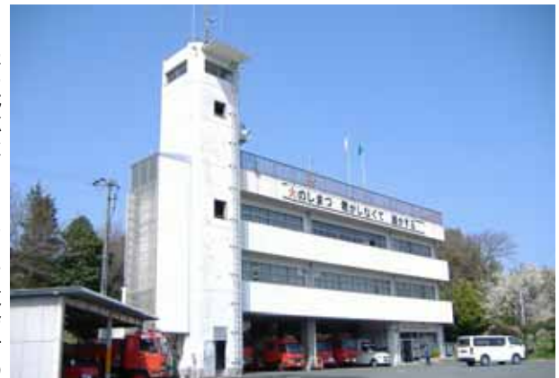
平成22年度中に移転する消防庁舎
