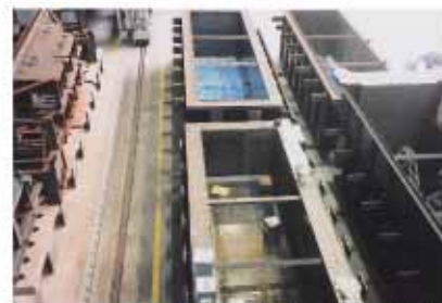
電解装置内部 FRPライニング施工中
