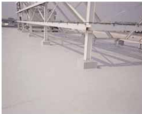
屋上部FRPライニング
