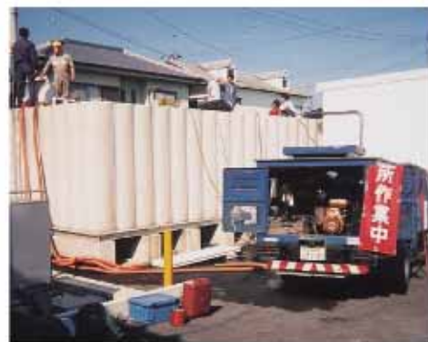
FRPタンク内の清掃
