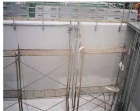
コンクリート構内 薬品工場廃液処理槽
