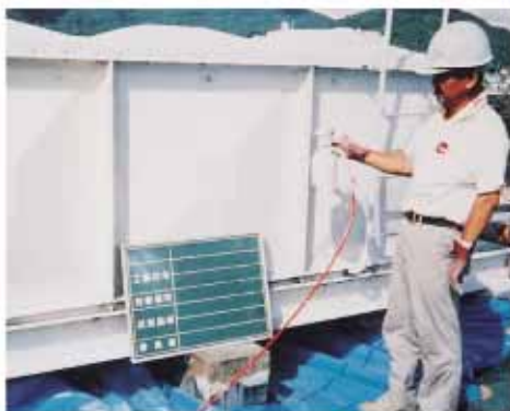
FRPタンク外観再塗装工事
