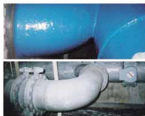
鋼管腐食FRPライニング
