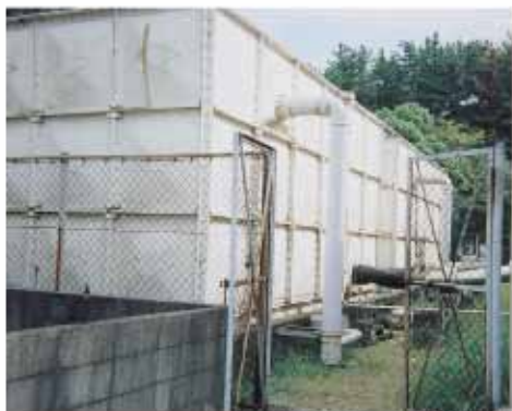
FRPタンク再塗装工事
