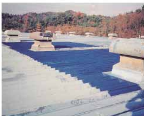
屋根ライニング
