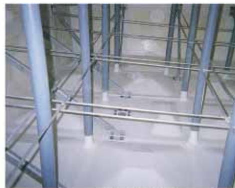
FRPタンクのリニューアル
