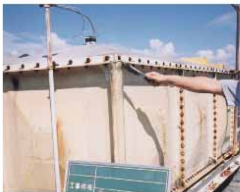
FRPタンクの再塗装工事前
