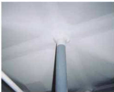
FRPタンクのリニューアル
