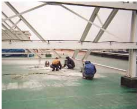
屋上部FRPライニング
