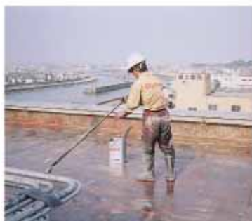
プライマー塗布
