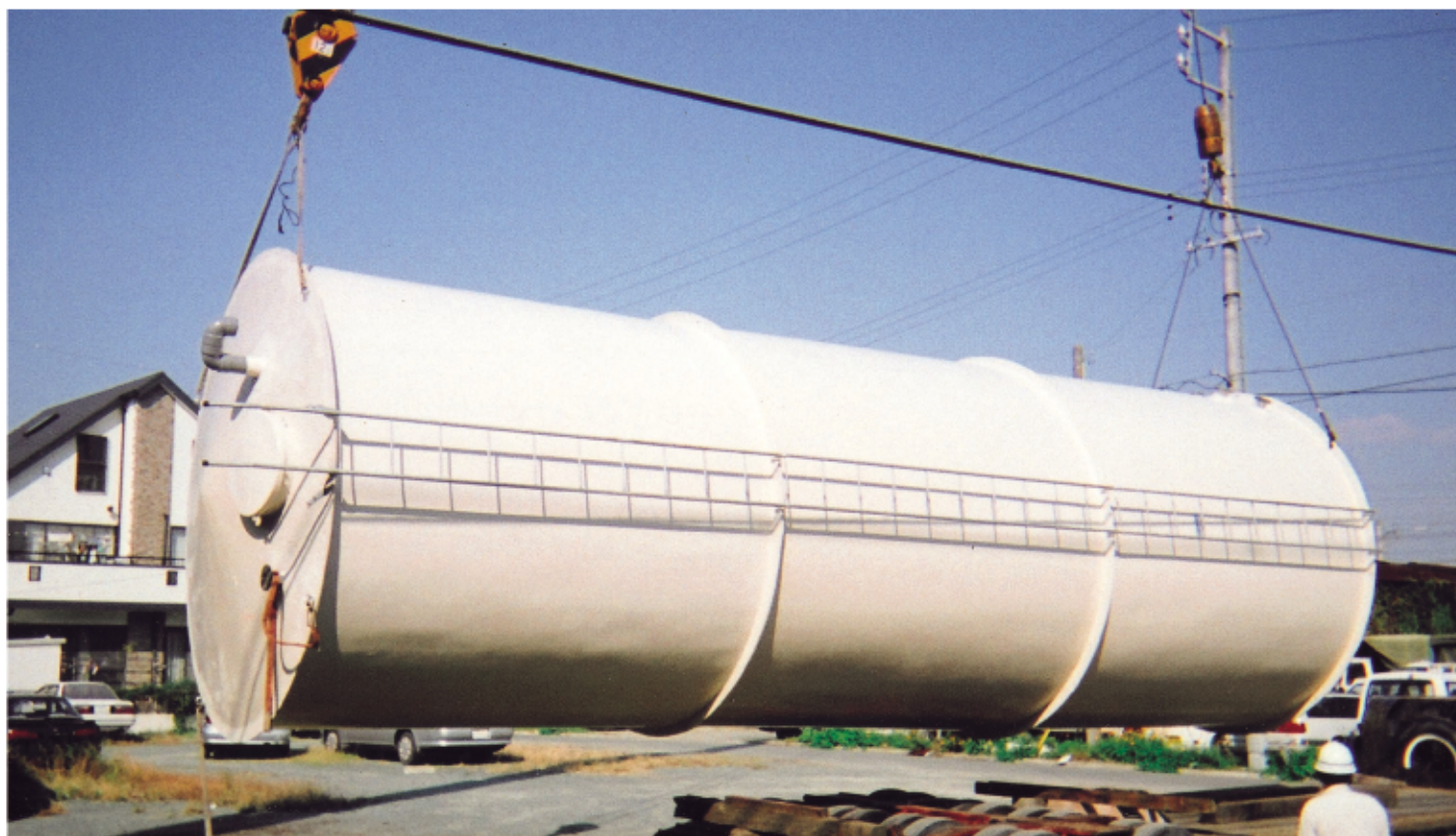
大型FRPタンク
